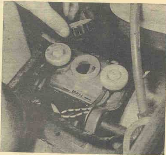
Réservoir de liquide de frein avec repères (Photo RTA)
